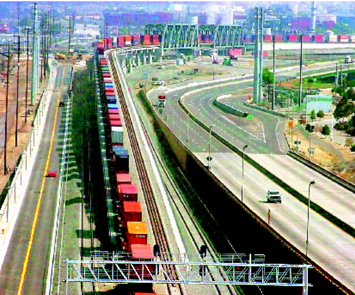
EL ALAMEDA CORRIDOR , proyecto en que trabajó el nicaragüense Jorge Molina, cruza las fronteras de las ciudades de Vernon, Huntington Park, South Gate, Lynwood, Compton, Carson y Los Ángeles, en California.
